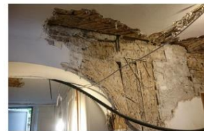
Wandaufbauten, die erst im Zuge des Rückbaus sichtbar werden und bewertet werden können.
