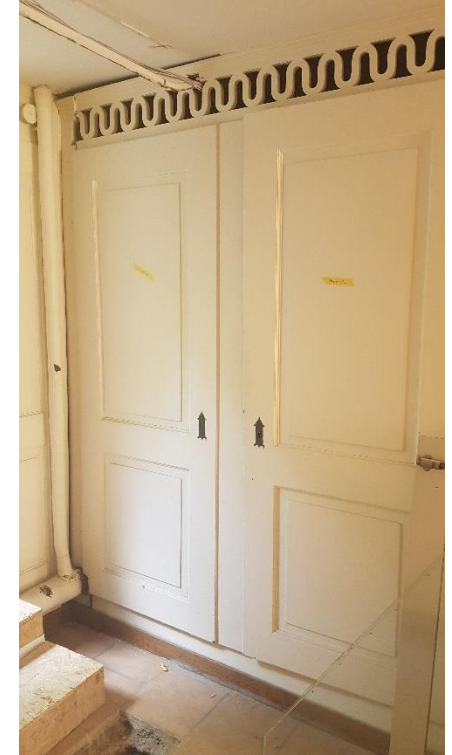
Brennbare Bauteile im vertikalen Fluchtweg, Haus denkmalgeschützt (abstrakte Gefahr)
