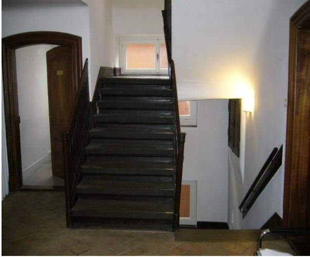
Brennbare Bauteile im vertikalen Fluchtweg, Haus denkmalgeschützt (abstrakte Gefahr)
