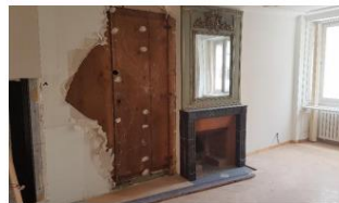
Wandaufbauten, die erst im Zuge des Rückbaus sichtbar werden und bewertet werden können.
