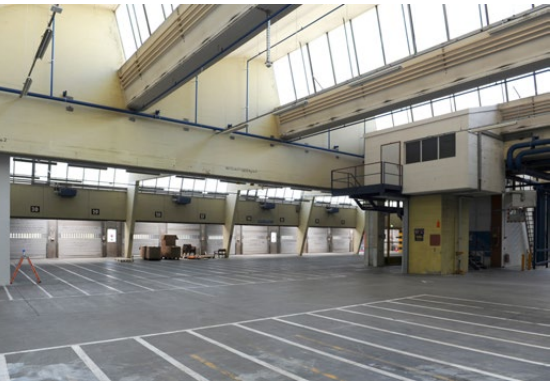
Blick in die Shedhalle der ehemaligen Coop-Verteilzentrale.
