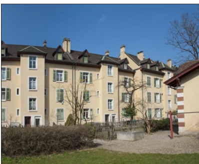
Thema Sanierung: Tellplatzhäuser von 1892 der GEWONA NORD-WEST.
