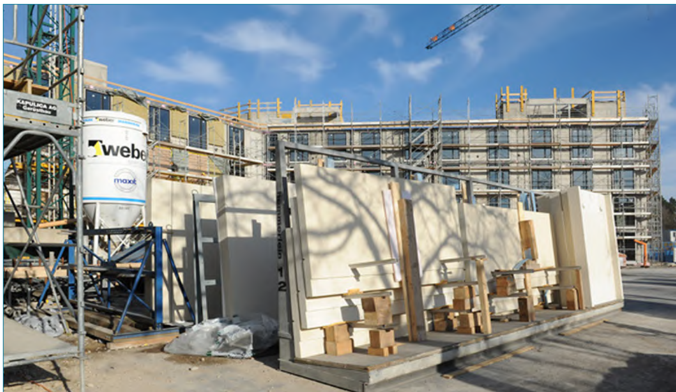
Wohnstadt: Riesige Fassadenelemente stehen bereit zur Montage. Belforterstrasse beim Bachgraben, Basel.
