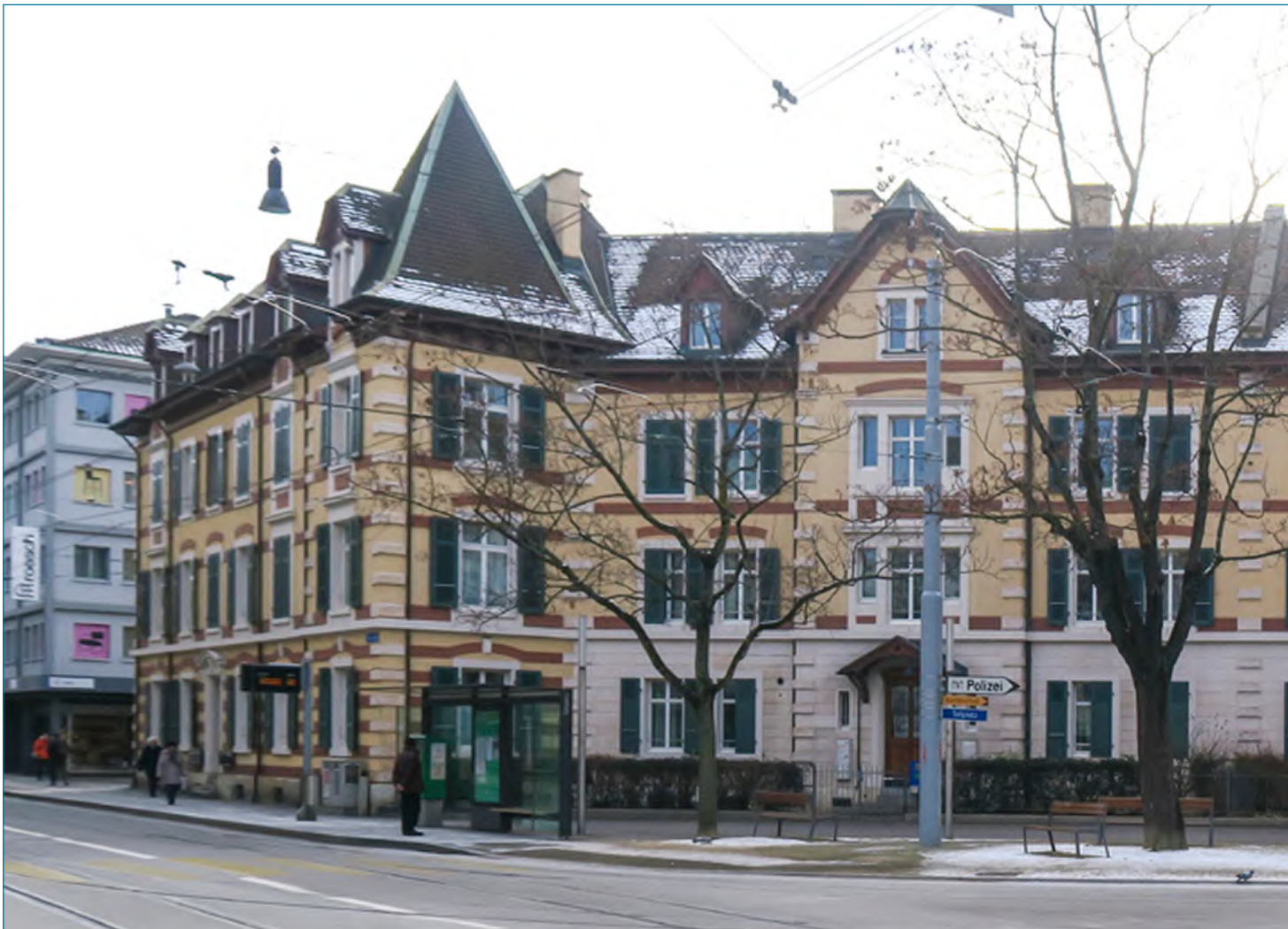
GEWONA NORD-WEST: Winterstimmung am Tellplatz. Die 125-jährigen Eisenbahnergenossenschaftshäuser mit renovierter Fassade und neuen Fenstern. Tellplatz, Basel
