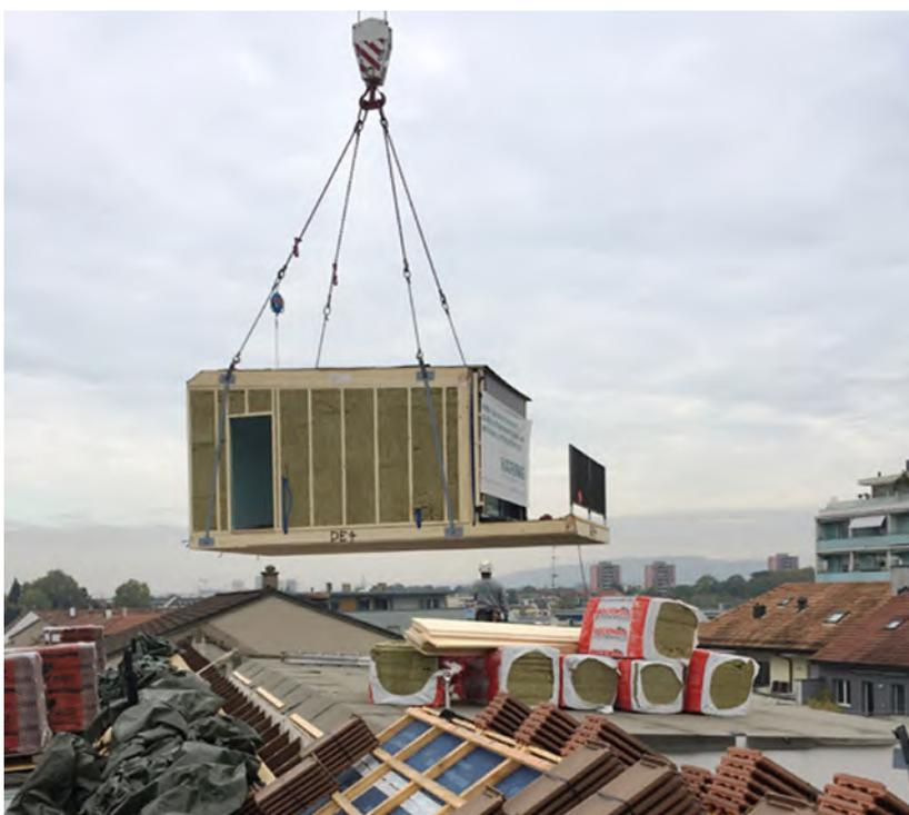
**Wohnraumerweiterung an nur einem Tag durch Modulbau:** Im Zuge der Dachsanierung erweitert Wohnstadt an der Homburgerstrasse in Basel 4 Zweizimmerwohnungen zu Vierzimmer-Maisonettewohnungen. Auf der Hofseite wurden acht fixfertige Zimmer auf dem Dach montiert und mit einer internen Treppe mit den darunterliegenden Wohnungen zu Maisonettewohnungen zusammengeslossen. Foto: wohnstadt
