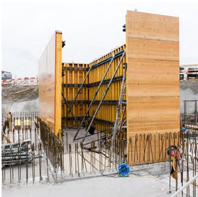
Sonnenfänger: Die Arbeiten auf dem riesigen Baufeld schreiten schnell voran. Foto: © B. Haberthür.
