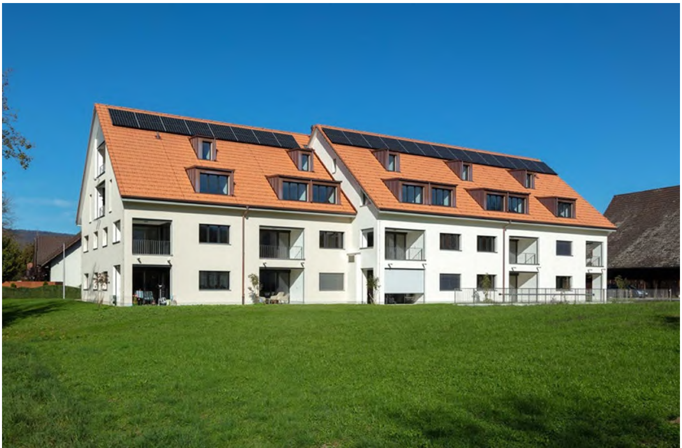
Wohnen an der Lüssel, Brislach: Nach einem 20 Jahre dauerndem Hürdenlauf konnten die 15 Wohnungen am 14.9.2019 unter kirchlichem Segen eingeweiht werden (vgl. Foto S.42).
