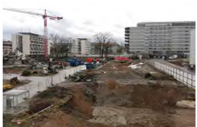
Westfeld: im Hintergrund der Baustelle das ehemalige Spital. Foto: Monika Willin
