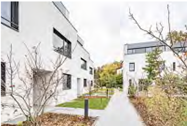
BWG Höflirain: 7 EFH in Riehen. Foto: Fox-Wälle Architekten Basel
