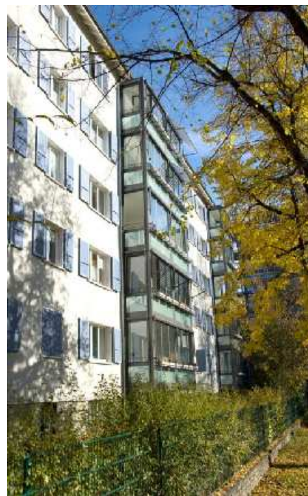
Gärtnerstrasse und Kleinhüningerstrasse mit neuen Wintergärten
