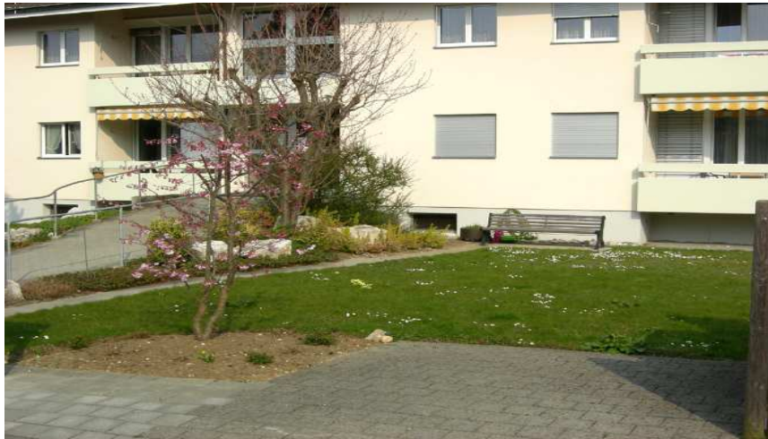
Alterswohnungen Kirschgartenstrasse Pratteln
