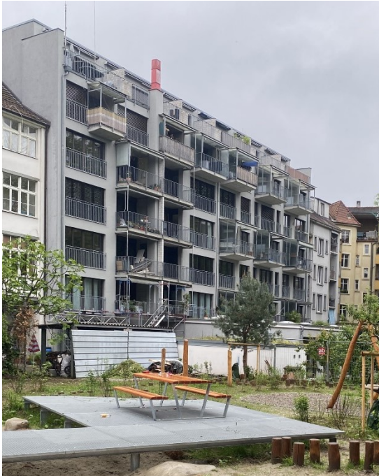
Wohnstadt + WG Elsässerstrasse 131 (2023)
