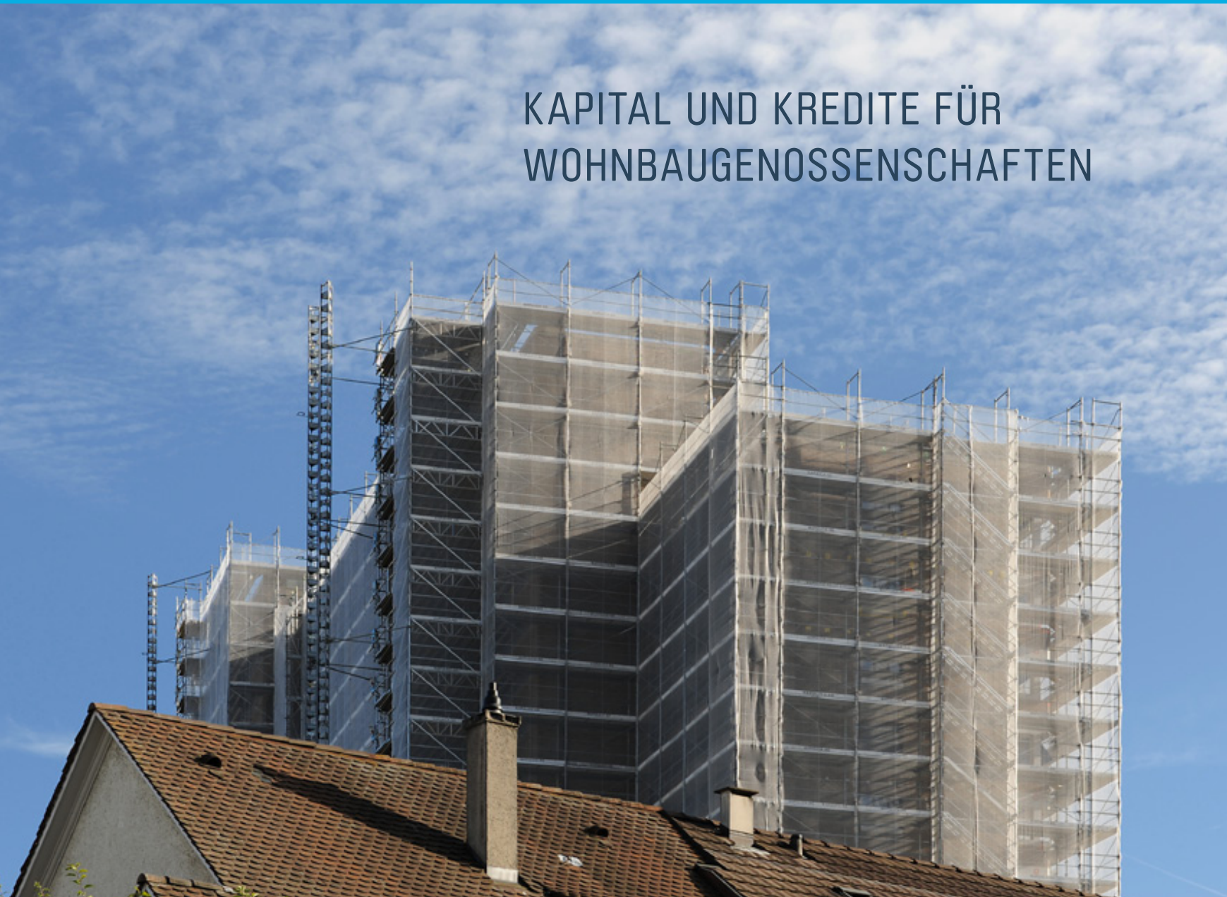
Abb 111: Fassadensanierung des Hochhauses Waldhof an der Reinacherstrasse
