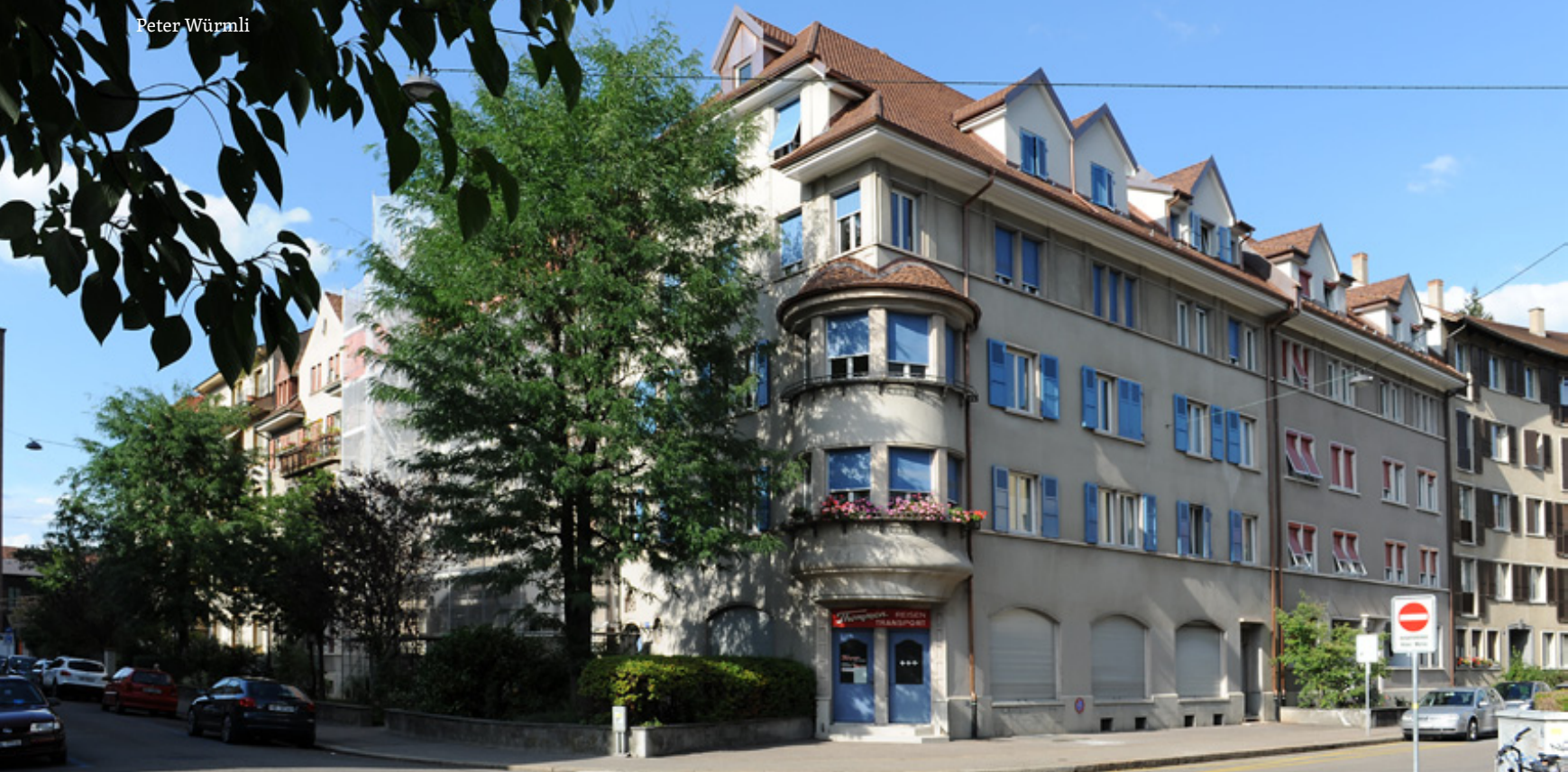
Abb 5: Erstes genossenschaftliches Bauprojekt: Überbauung der Basler Wohngenossenschaft an der Buchen-/Eichenstrasse von 1912–13
