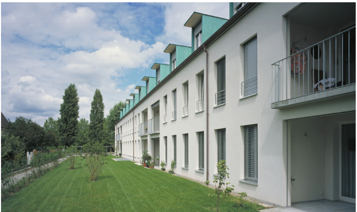
Abb 65: Häuserzeile von aussen
