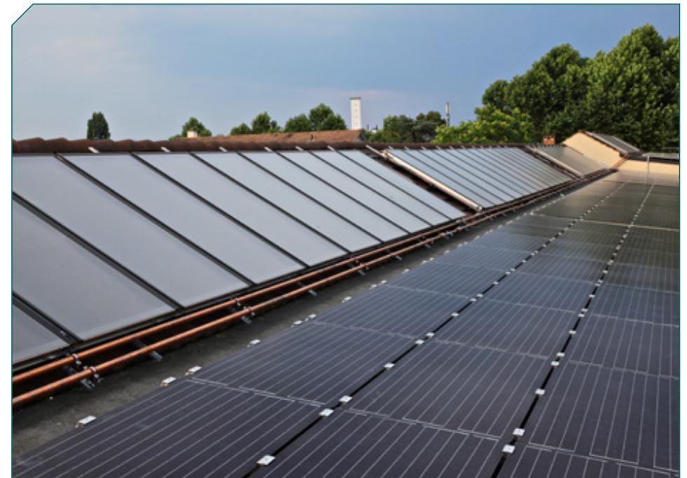
**WG Neubad, In den Ziegelhöfen, Basel:** Kombinierte Warmwasser- und Photovoltaikanlage mit 154 m<sup>2</sup> Kollektorfläche respektive maximale PV-Leistung von 40 kWp. Die Kollektoren bedienen 2 × 6000 Liter Solarspeicher und 1200 Liter Wassererwärmer. Zusätzlich Kaltwasserversorgung aller Häuser inkl. Filteranlage.
