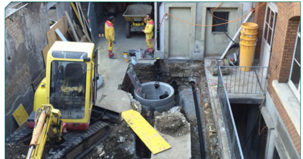
Rege Sanierungstätigkeit: Wohnstadt Umbau an der Mörsbergerstrasse 52 in Basel
