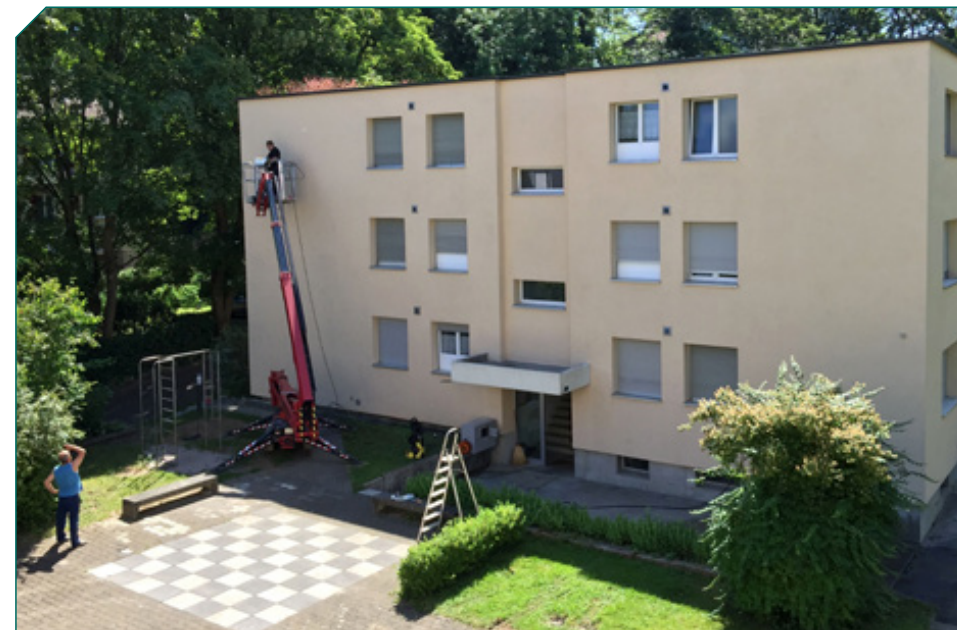
Die Wohngenesschaft des Bundespersonals Liestal sanierte am Kesselweg 23 und 25 ihre aus den 60er-Jahren stammenden Liegenschaften umfassend und zeitgemäss.
