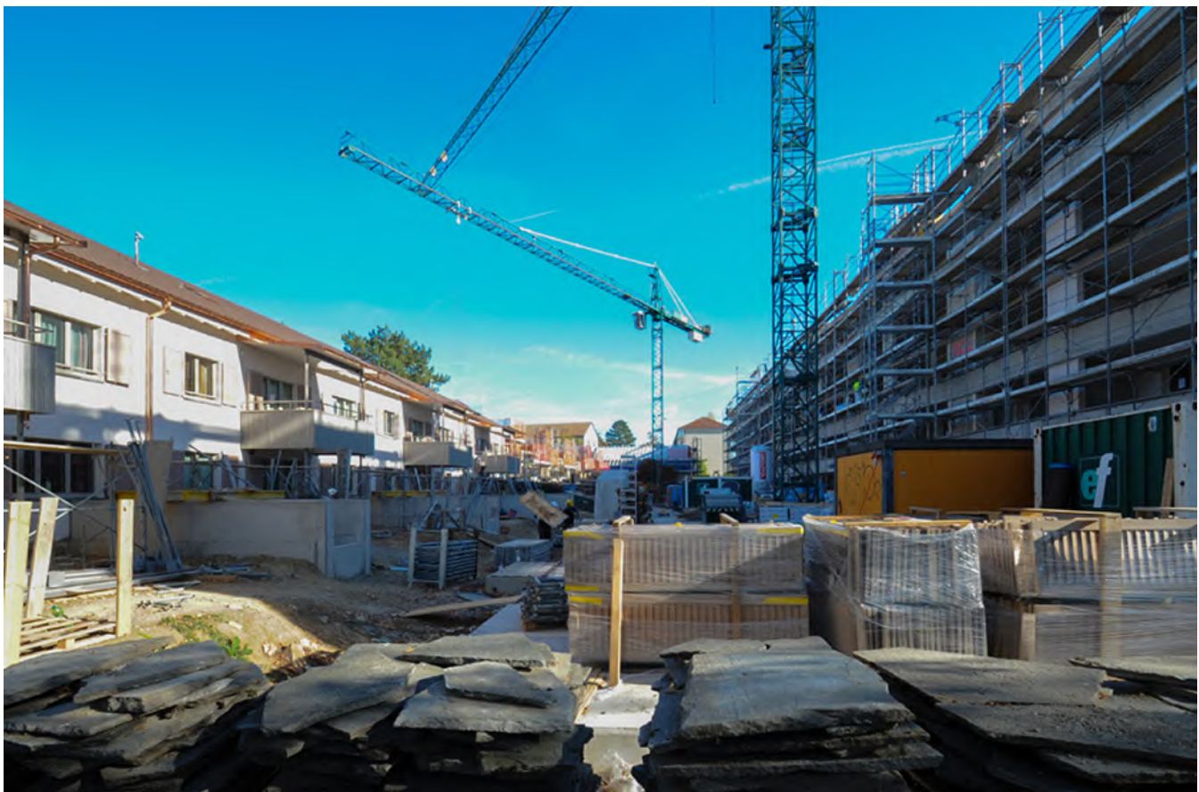
WG Belforterstrasse: Sie sind mit ihren Sanierungsarbeiten wieder einen Schritt weiter. Links die fast fertig sanierten EFH, rechts wurde die Fassade angegangen. Die Einstellhalle unter den Kränen ist bereits fertiggestellt.
