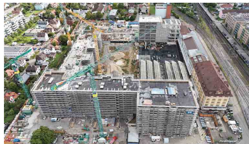
Die Arbeiten auf der Zentrale Pratteln gehen zügig voran © Robert Mikolaizak
