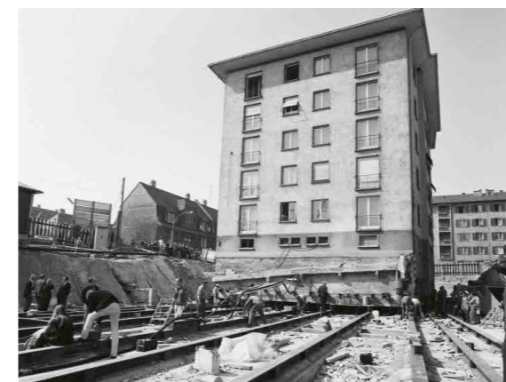
Die Hausverschiebung über hydraulische Pressen © WG Redingbrücke
