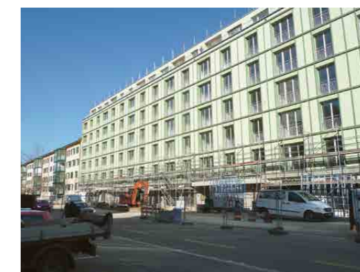
Im Ersatzneubau an der Lehenmattstrasse 233–239 entstand mehr zeitgemässer Wohnraum © EBG
