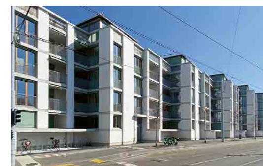
Auch mit der NWG hat René Brigger für neuen Wohnraum gesorgt © NWG, Guido Köhler
