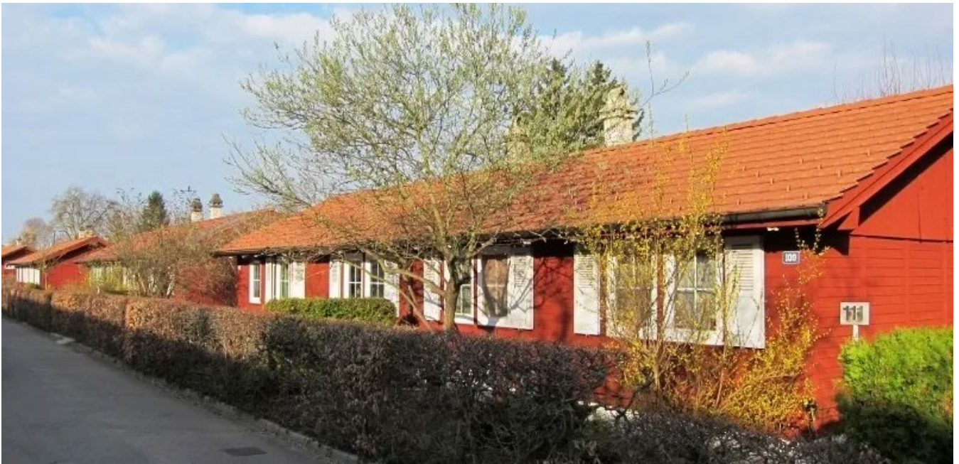
BWG Im Landauer: Die 52 Holzbauten aus den Jahren 1943-1947 wurden in kostengünstiger NILBO-Bauweise von Hans Bernoulli entwickelt. Im Zusammenhang mit der Verlängerung des Baurechts ist eine bauliche Verdichtung geplant. Foto: zVg.
