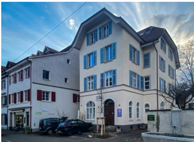
Alte Post: Die Liegenschaft im Zentrum von Riehen umfasst die Gebäude rechts und links. Im linken Teil ist ein Laden für mexikanische Spezialitäten untergebracht. Foto: Guido Köhler
