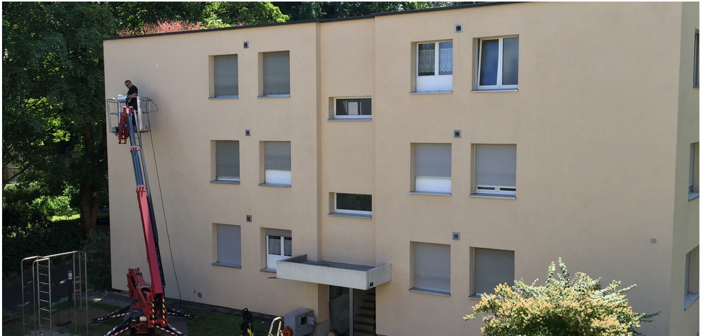
2015 wurde die Fassade mit Hilfe einiger Mieter heruntergewaschen.
