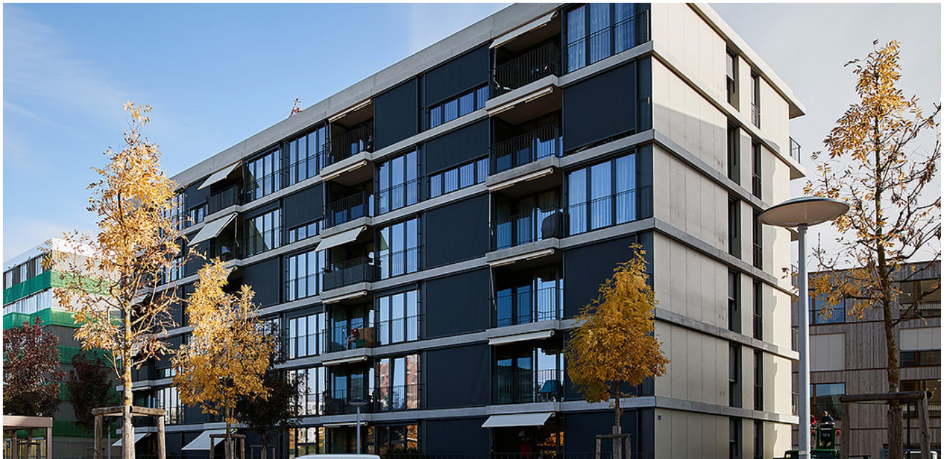
Die neuste Errungenschaft: Die Liegenschaft am Goldbachweg 4-6 im Basler Erlenmatt-Quartier.
