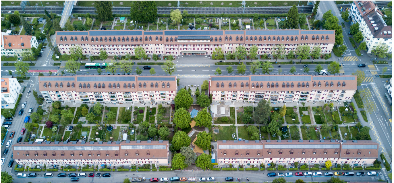
Kompakt: Ganz vorne die Häuser der Rigistrasse, dahinter die beiden Wohnblöcke am Morgartenring.
