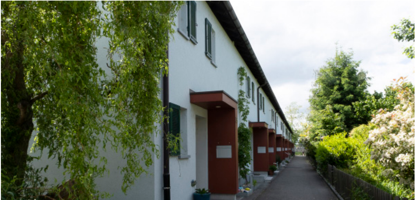
Die Einfamilienhäuser an der Michelbacherstrasse im Basler Quartier Burgfelden.
