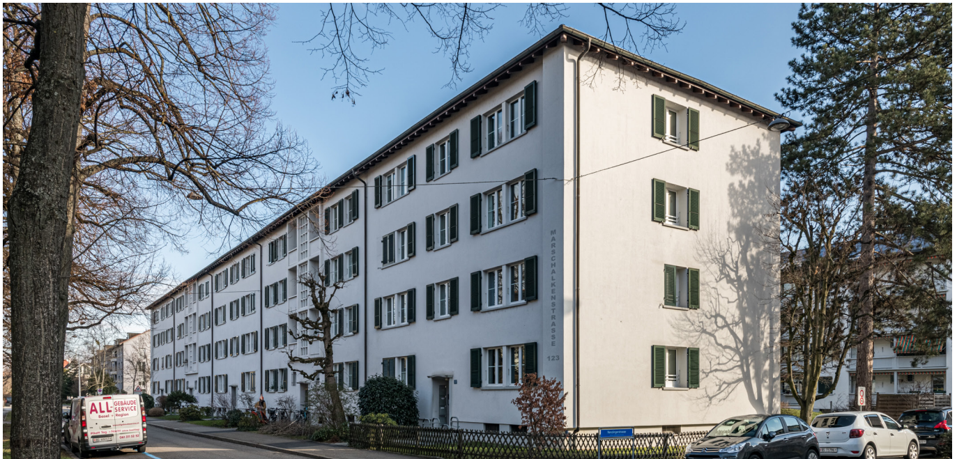
Auch die Mieterinnen und Mieter an der Marschalkenstrasse 115-127 haben neue Bäder erhalten.
