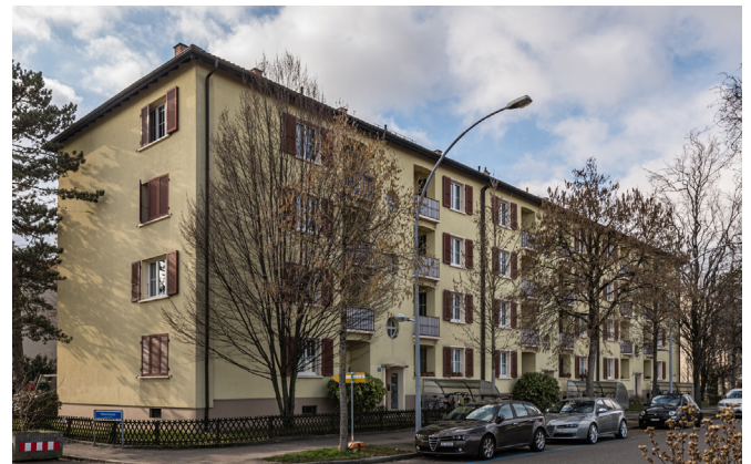
Häuserblock an der Wanderstrasse 161-165.
