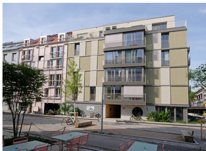
Beckenweg 11 auf dem Lysbüchel-Areal.
