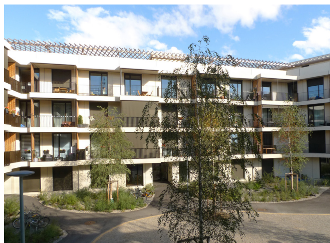
Belforterstrasse 140-150 beim Bachgraben.
