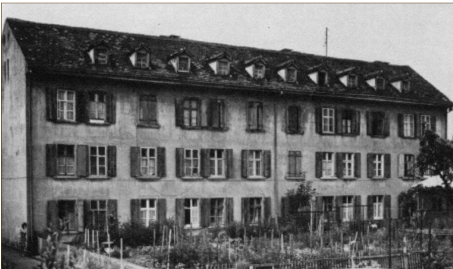
Abb. 2: Siedlung der AG für Arbeiterhäuser in der Breite
