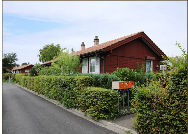
Abb. 26: Holzhäuser der Bau- und Wohngenossenschaft im Landauer
