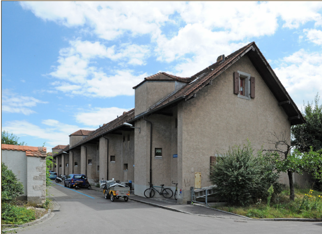
Abb. 25: Siedlung der Wohngenossenschaft Drei Linden
