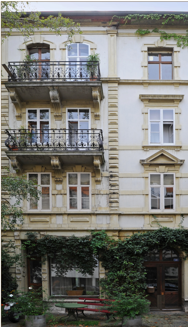
Abb. 33: Davidsbodenstrasse 19, von der Genossenschaft St. Johann sanft renoviert
