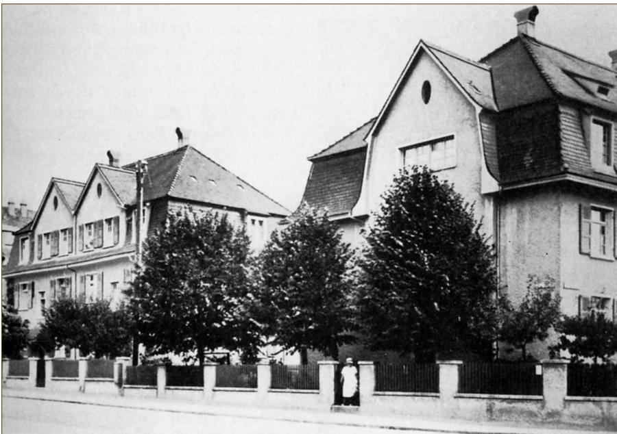
Abb. 4: Siedlung Birs I der Eisenbahner-Baugenossenschaft
