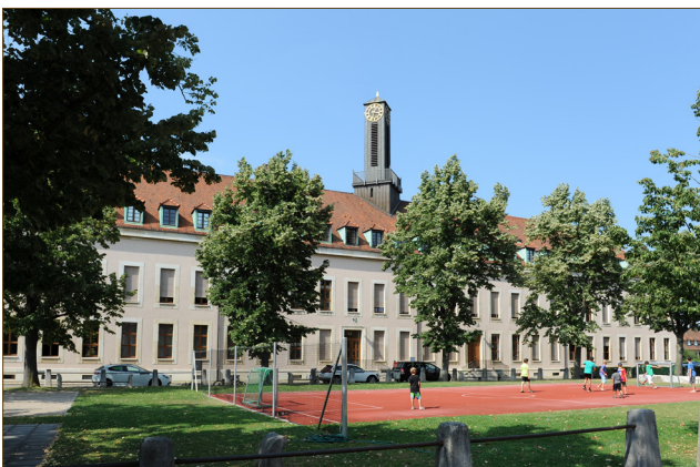
Abb. 9: Siedlung Freidorf in Muttens: Gemeinschaftsgebäude
