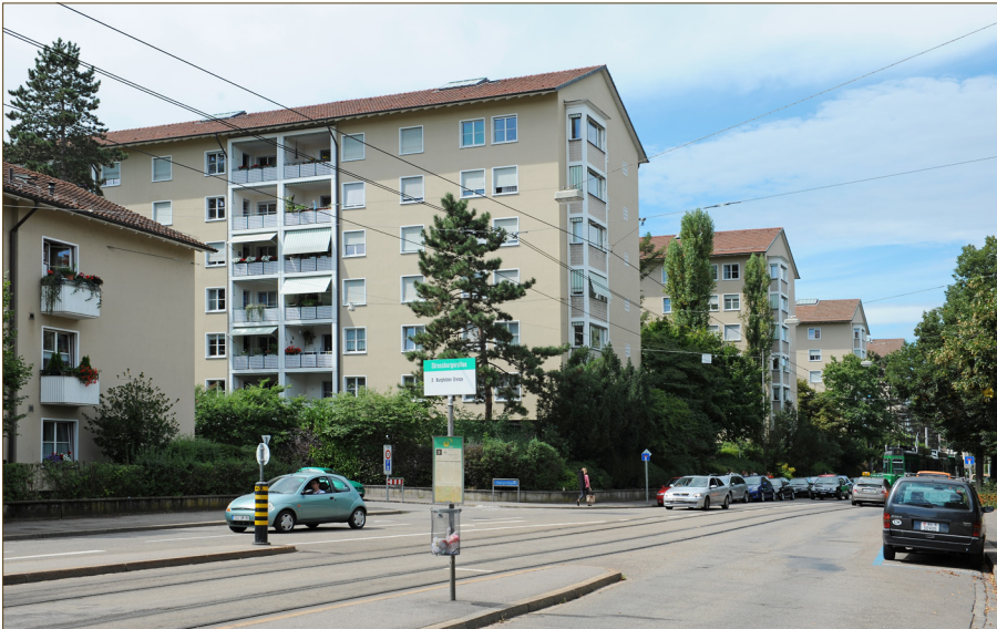
Abb. 23: Mehrfamilienhäuser der Wohngenossenschaft Kannenfeld
