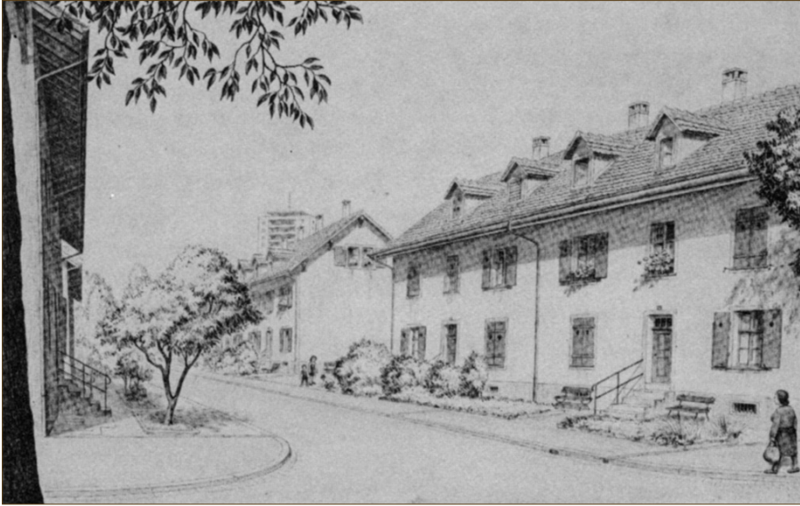
Abb. 3: Arbeiterhäuser am Ulmenweg
